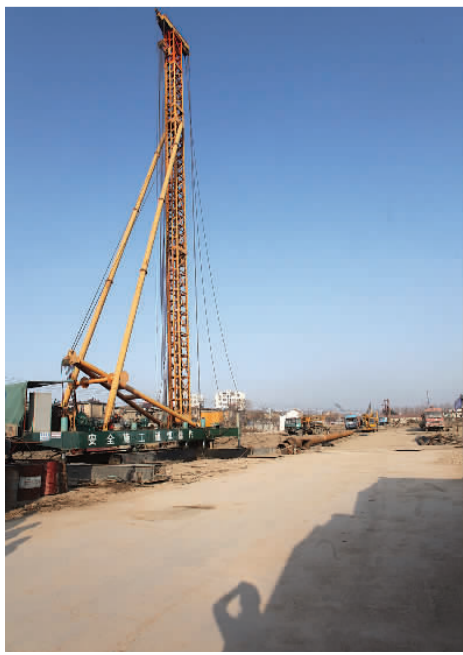
金凤小区施工现场
