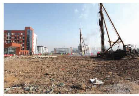
康达学院施工现场
